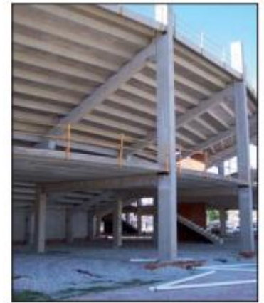
Gradas en Plaza de Toros de Villa Prado
